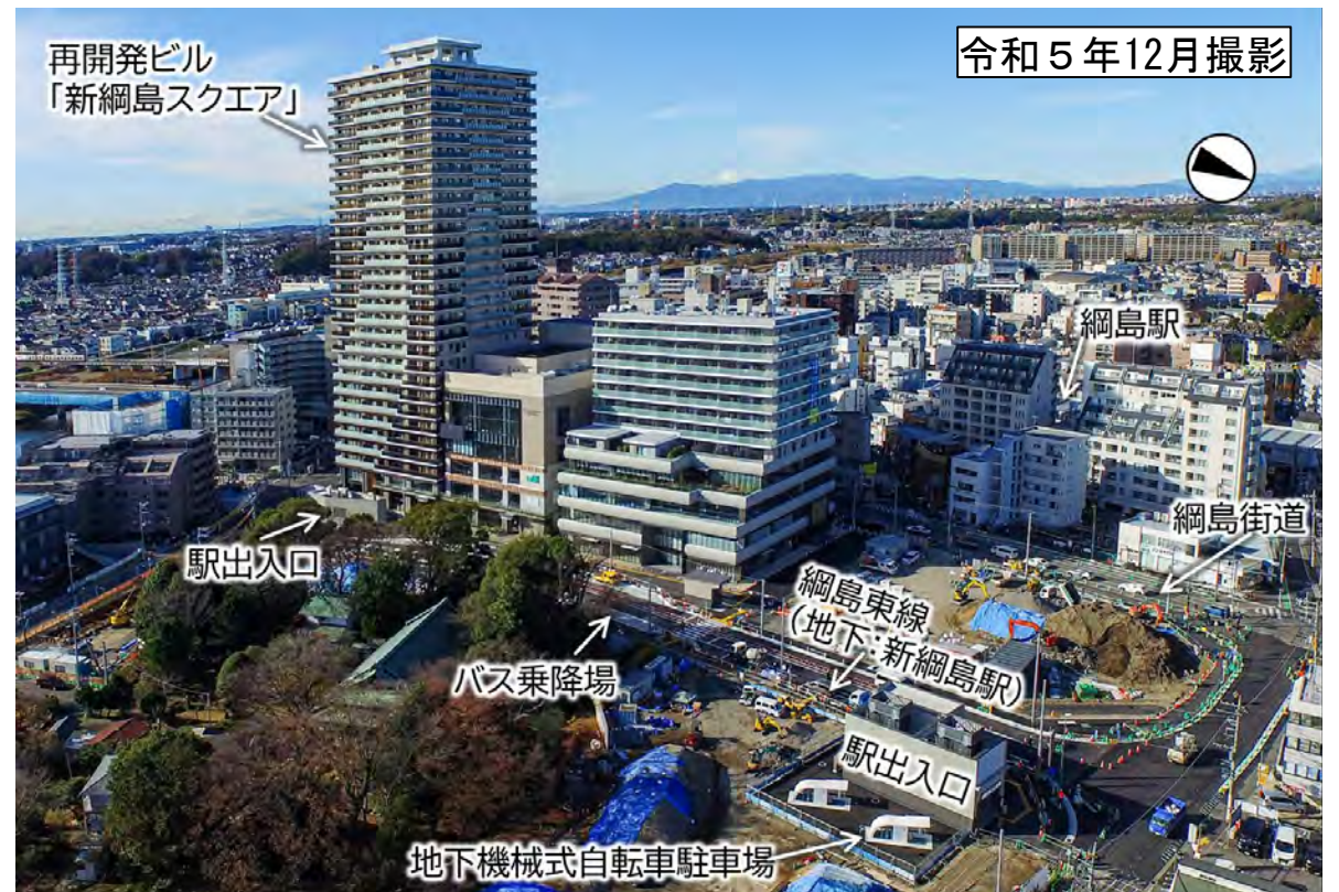
新綱島駅周辺地区の状況
