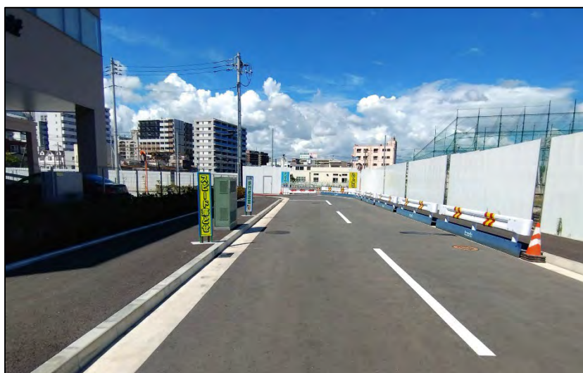
地区内道路の一部完成
